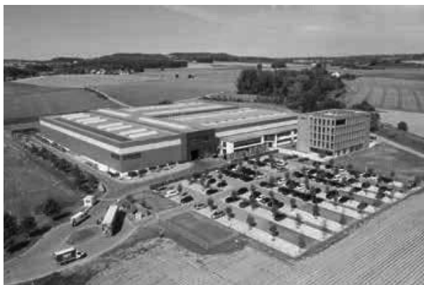
Foto: STADLER Anlagenbau GmbH
