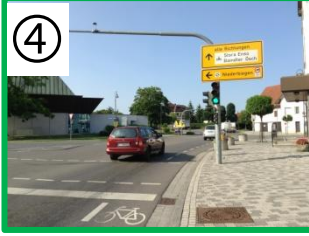
4 An der Kreuzung am Hallenbad gibt es für die Radfahrerfurt eine extra Radfahrerrampel. Diese schaltet für Radfahrer früher auf Grün aber auch wieder früher auf Rot. Bitte gebt Acht, wenn LKW auf der Straße vorbei fahren. Benutzt die Schutzstreifen in Fahrtrichtung rechts!
